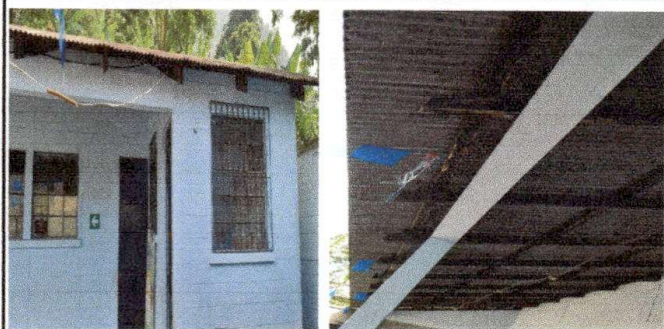
Foto 1: Sustrucción de lámina, por lámina troquelada aluzinc calibre 26 y sustrucción de estructura de soporte de madera por metal.
