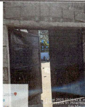
Foto 2: Mantenimiento a estructura (portón)
